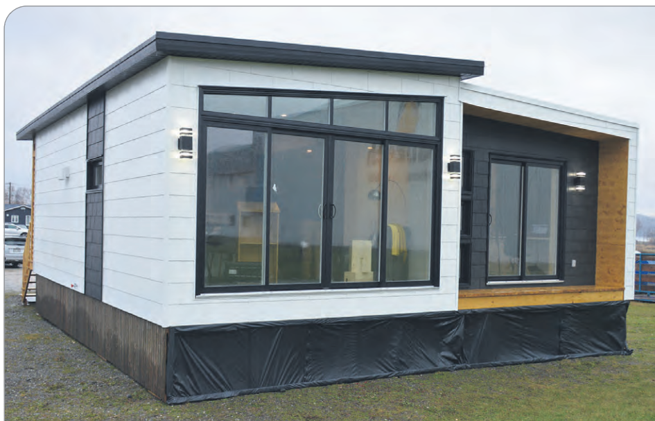
La maison Amalgame est fabriquée en usine et installée par Batitech de Témiscouata-sur-le-Lac.
