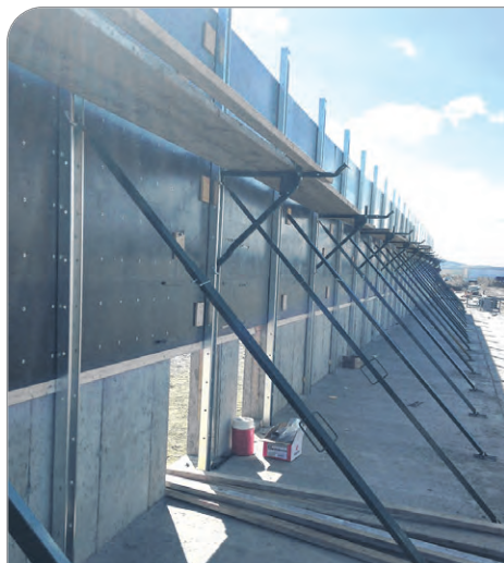
Lors des travaux de construction d'une porcherie à Saint-Honoré-de-Témiscouata.
