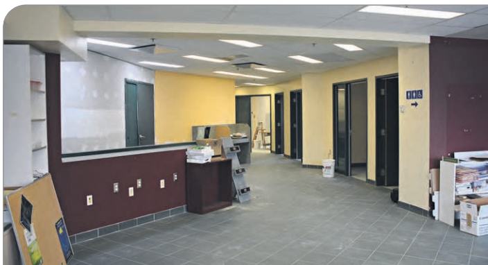
Les travaux sont déjà amorcés pour aménager les divers espaces de coworking. PHOTO : ANDRÉANNE LABEL
