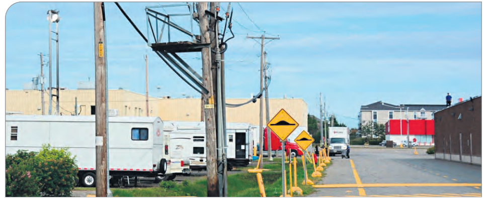
Les installations électriques du Centre commercial de Rivière-du-Loup. PHOTO : ARCHIVES, ANDRÉANNE LABEL
