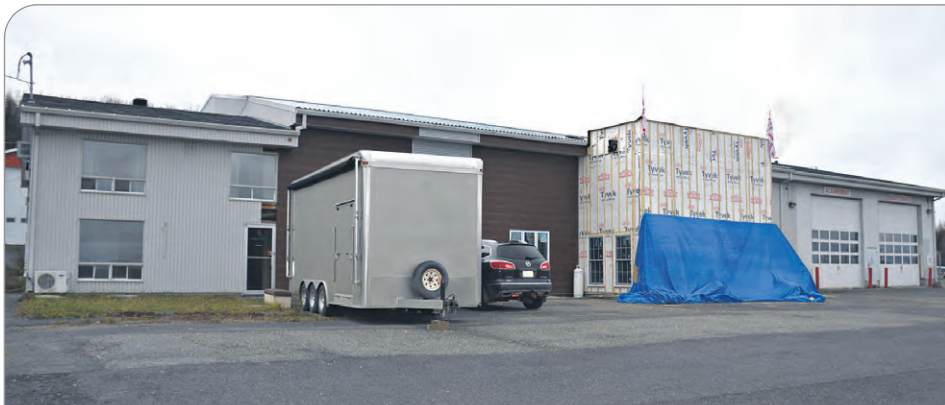
On aperçoit au centre la construction d'une nouvelle entrée. PHOTO : MARIO PELLETIER
