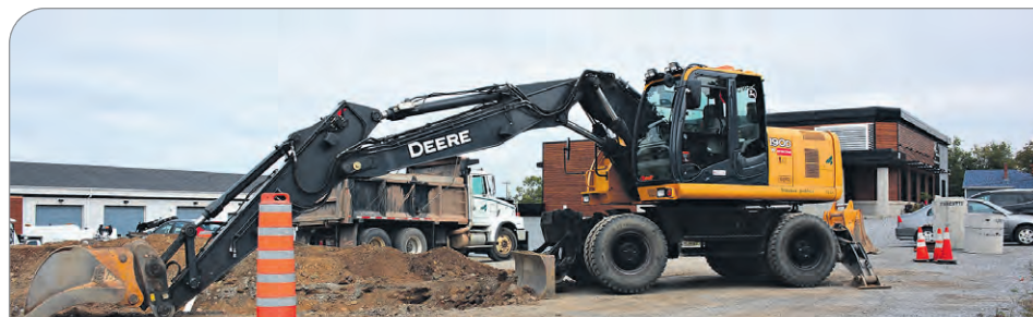
Les travaux ont été entamés il y a peu. PHOTO : ANDRÉANNE LABEL
