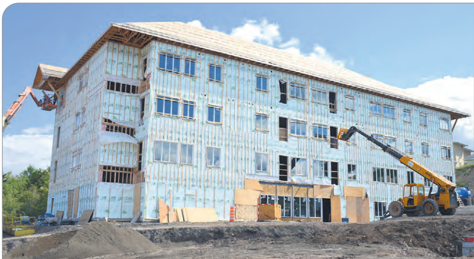
Le Manoir Saint-Antonin en construction. PHOTO : MARIO PELLETIER
