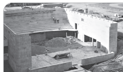
Construction du Centre culturel de Rivière-du-Loup, 1966.
