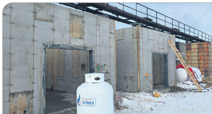
Les travaux de réaménagement des fours de carbonisation ont eu lieu durant l'hiver.
