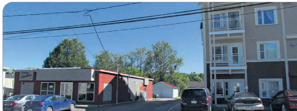
Les anciens bâtiments de la Boucherie Bégin seront démolis ou démenagés pour faire place à la troisième phase du Manoir Rose-Marquis. PHOTO : PATRICE PICARD
