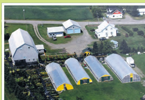
L'ensemble des bâtiments de l'entreprise Les Serres Chouinard.
