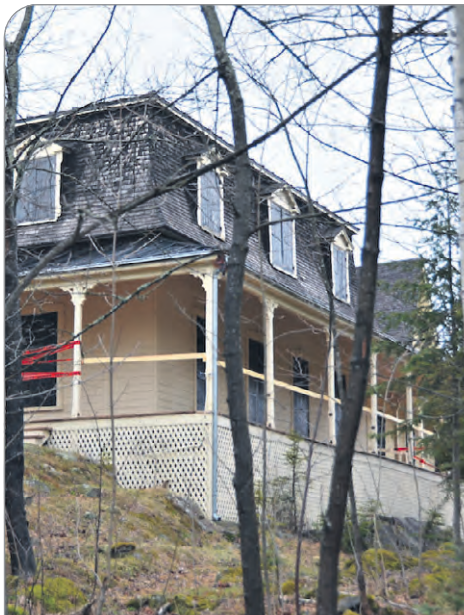
La Maison d'été Sir John A. Macdonald. PHOTO : MARC-ANTOINE PAQUIN
