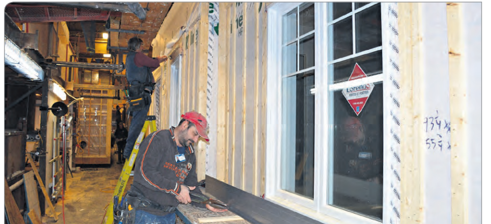
Des employés travaillant sur des modules préfabriqués dans l'usine Goscobec. PHOTO : MARIO PELLETIER
