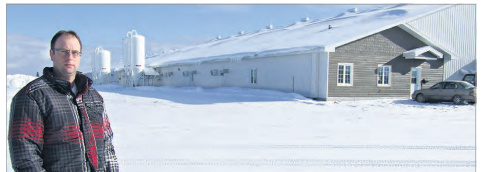
Cette maternité porcine a été réalisée en 2015 par Construction J. Tremblay inc.
