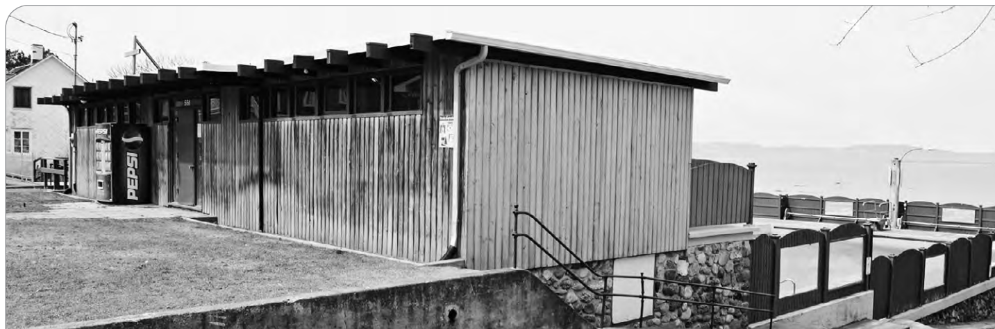
La piscine extérieure et son bâtiment de services actuel. PHOTO : MARIO PELLETIER
