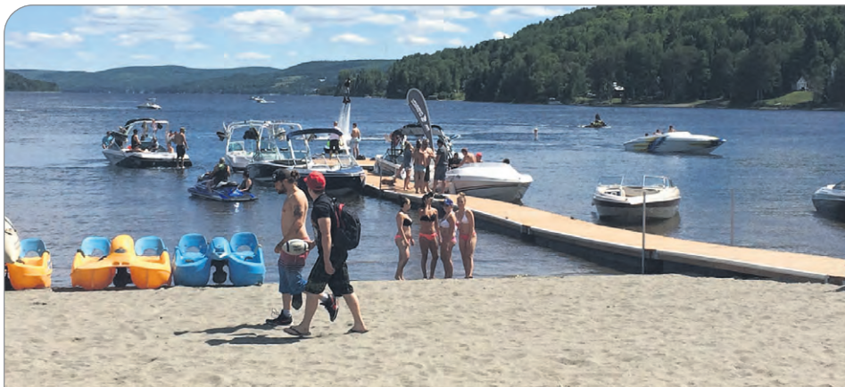
Le nouveau quai accroît la sécurité et la capacité d'accueil des visiteurs au Centre touristique.
